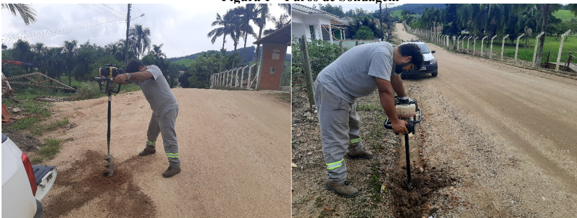
Figura 1 – Furos de Sondagem
